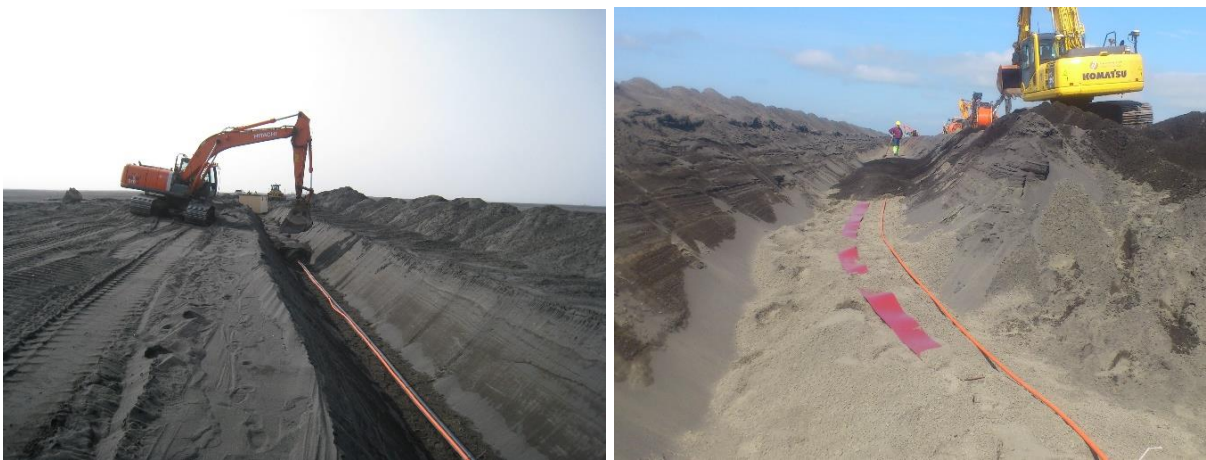
Mynd 5.1 Lagning jarðstrengs VM3 í skurð á Landeyjasandi (vinstri) og hlífðarborði og fjarskiptarör vegna jarðstrengs VM3 (hægri).
