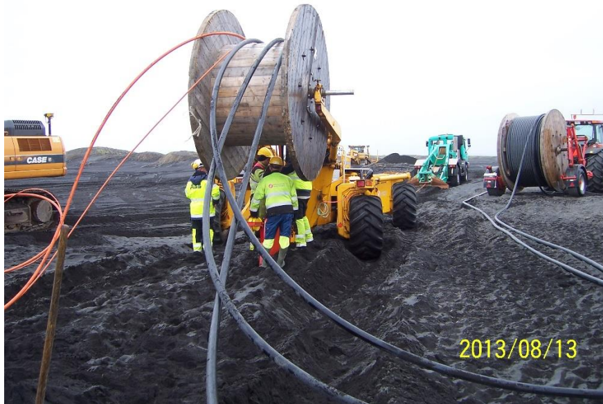
Mynd 5.3 Strengkefli á keflavögnum sem notaðir eru við lagningu jarðstrengs.
