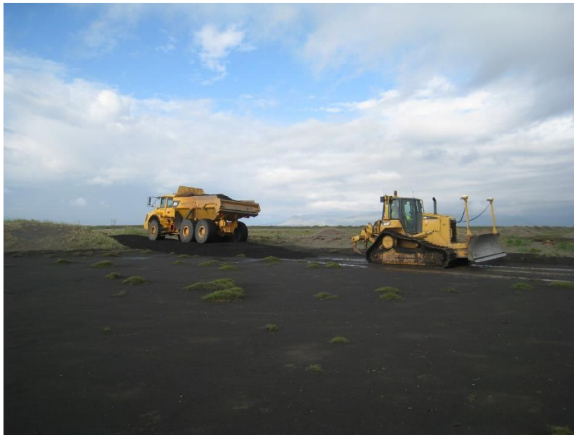
Mynd 5.5 Lagning slóða á Landeyjasandi vegna jarðstrengs VM3.
